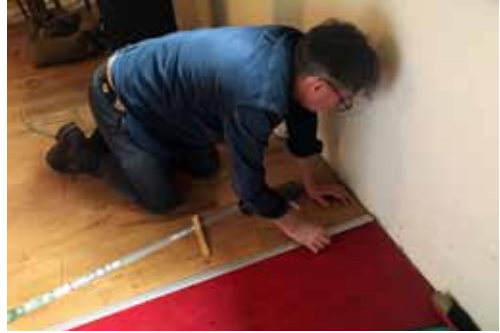
Plauder montiert äußerst akribisch die Übergangsleiste. Zuvor hatte hagzissa ebenso akribisch die Kauzkacke beseitigt.
